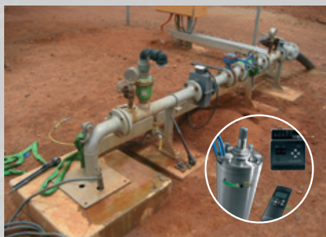
Kontrola wód gruntowych
