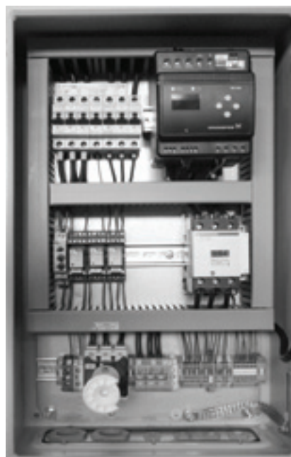
Rys. 13 Widok wewnętrzny MP 204
