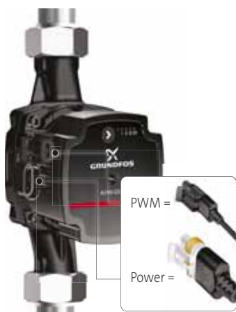
Rys. 9 Przyłącza skrzynki sterowniczej
